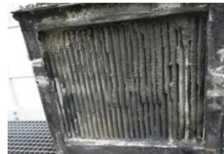
← Durch Tropfenmitriss mit Aschepartikeln belegter Abscheider
